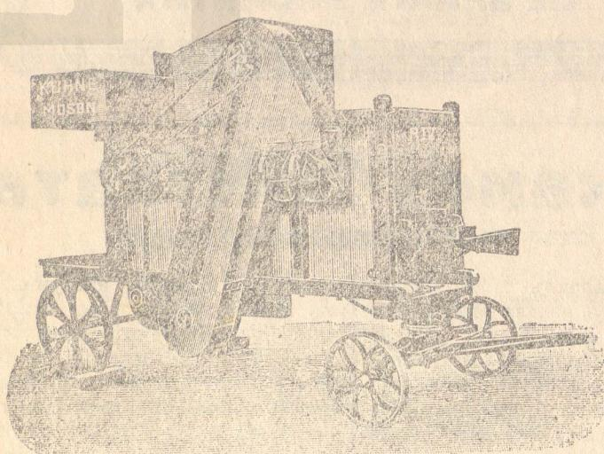
Съ вентилаторъ, елеваторъ и чистиленъ апаратъ. Производство дневно 1 1/2 — 2 вагона. Продава се съ лежащо петролно моторче 3 к. с., монтирано на същата колесница.
