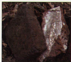
Обр.2. Фрагмент от тухления пояс на западната стена на крепостта Маричино градище. Наблюдават се тухлени редове свързани с червен хоросан / хоросан с добавка на стрита керамика/
