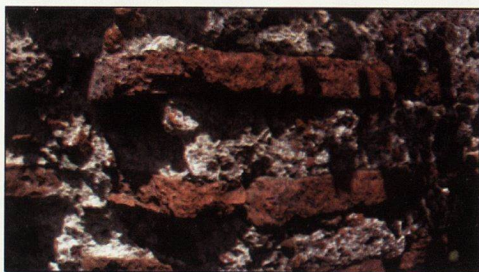
Обр.2. Фрагмент от тухления пояс на западната стена на крепостта Маричино градище. Наблюдават се тухлени редове свързани с червен хоросан / хоросан с добавка на стрита керамика/
