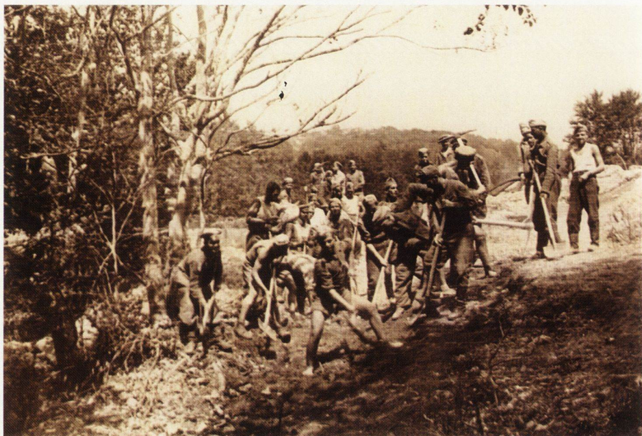
Строеж на пътя Сливен - Бяла, 1938 г.
