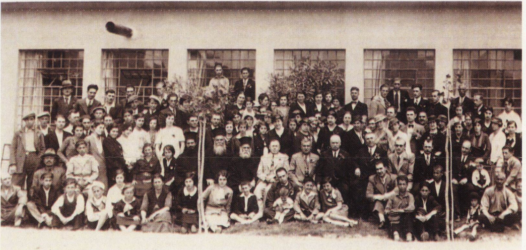
Освецаване на новопостроената фабрика за електрически лампи "Белфа", май 1934 г.
