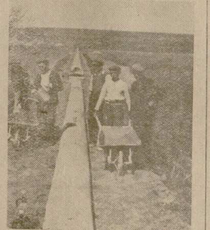
НА СНИМКАТА: Кооператорите в ТКЗС с. Козарево, Г. Оряховско строят напоителни канали.
