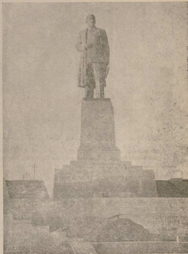
Паметник на великия архитект на комунизма Йосиф Висарионович Сталин при входа на Волго-Донския канал
