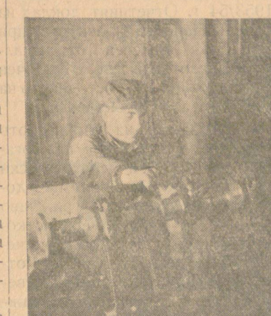
На снимката: — Йордан Николов Върбановски от МТС в с. Ресен — Търновско, пасва биялните лагери на последния за ремонт трактор „СТЗ-Нати“.
