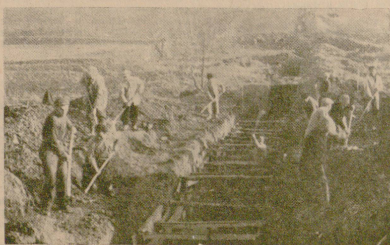
На снимката: Жителите на с. Кесарево, Горнооряховско строят основите на микрорязири, който ще снабди 700,000 куб. метра вода и ще напоява 2,000 декара
