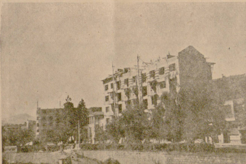
На снимката: В умелите ръце на строителните работници от РСУ — Габрово и РСР „Местни строители“ все по-гордо се издигат корпусите на жилищните блокове на ф-ка „Евтим Апостолов“ и на ГНСДТ — Габрово (в ляво) над река Янтра, зад алея от млади берези.
