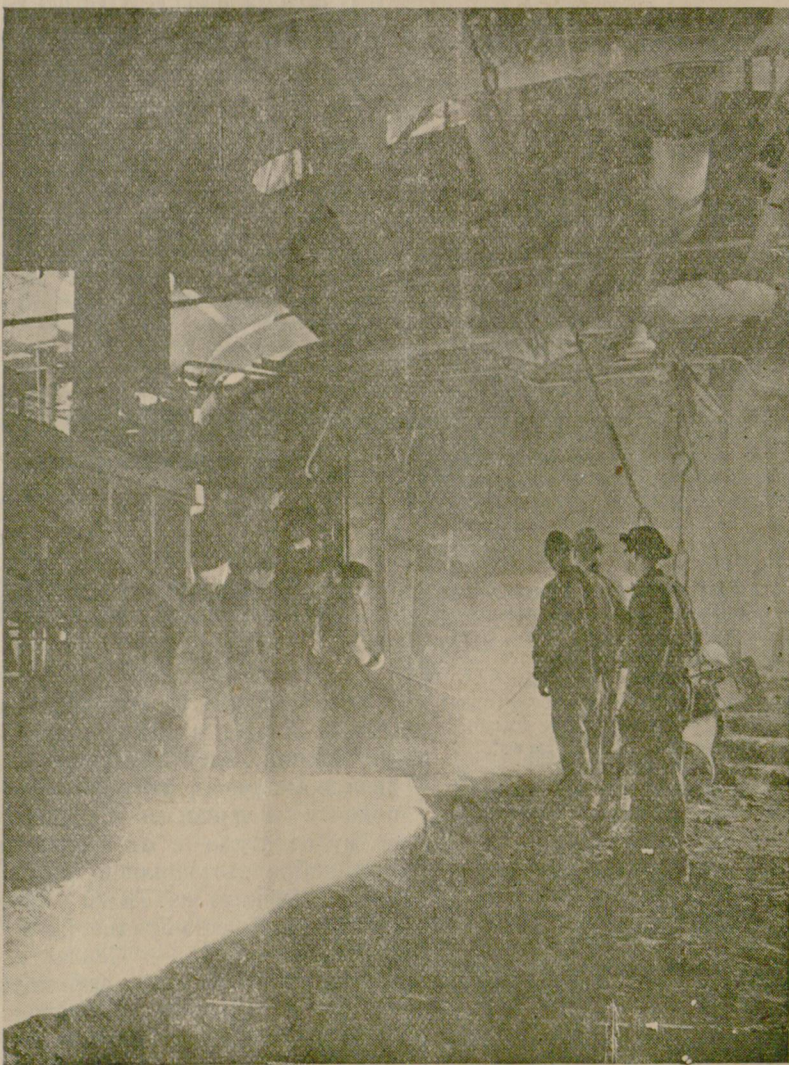
На снимката: Пушане на метала от доменната пещ.
