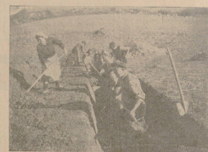
Зеленкувата бригада в с. Душево, Севлиево, вече няколко дни работи на местността „Бяло поле“ за построяване на малък язовир
