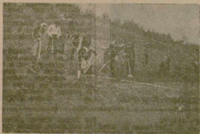
Младежите и девойките от с. Горско Сливово, Павликено, под ръководството на техниката по земостроителство Петко Петков терасират пустеещи места в местността „Сенокос“.
