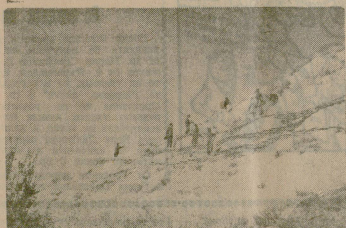
Група работници изграждат тераси с плетчета на стръмния бряг в местността „Функата“ — Севлиево
