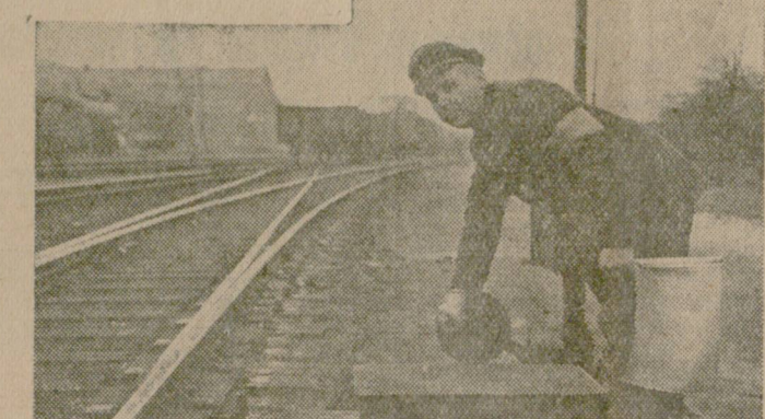
На снимката: Стрелочникът Христо Ковачев бързо обръща стрелката за идващия вагон при композирането на тежестоварен влак.
