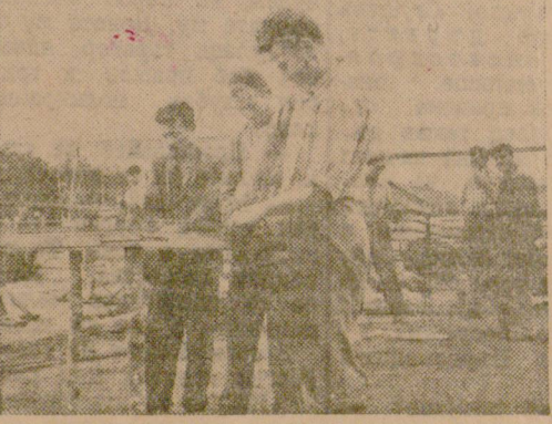
В социалистическото строителство на нашата Родина участват активно и жените. В полигона за виброемента-Горна Оряховица, под ръководството на бригадир Павел Нелъзов работи женска бригада. В момента на снимката тя изработва железобетонни рамки за прозорци на модерните птичарници към ТКЗС в Търновски, Коларовградски, Габровски и Търговишки окръг. В чест на 15-годишнината на Девети септември бригадата е обещала да изпълни поръчките 15 дни предсрочно. Аматристката бригада на Янко Илиев Костов при полигона изпълнява дневната си норма 200 на сто.
