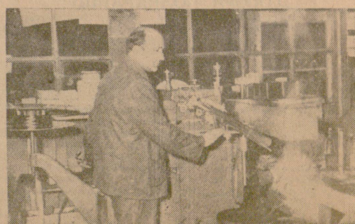
Шлосерът Тодор Роменов работи на новата българска машина, която произвежда спирални пружини.
