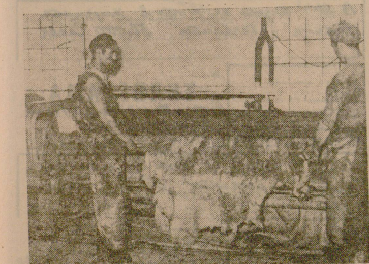
1. В пристройката напавена със средства за малка механизация в кожарската ф-ка „1 май“, Търново е инсталирана втора нова шервачна машина, която е пусната в експлоатация преди една седмица. 2. Кожарските работници Ст. Станчев, Я. Исмаилов и Яв. Яков препоставят фирмени кази, които са направени със средства за малка механизация. Престояването на кожите в тези кази е намаляно почти с един ден. Подобрено е състоянието на разтворите. В резултат на това се получава икономия на натриев сулфид. Вместо 24 кг за една партия сега се слага 5 кг. Освен това се запазва по-голямата част от косяма, който се използва за друг клон от индустрията ни. Снимка: М. Николов
