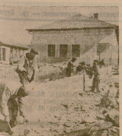
Строителната бригада на Стефан Н. Димитров работи за разширяване на климатския цех на градския промкомбинат Елена.
