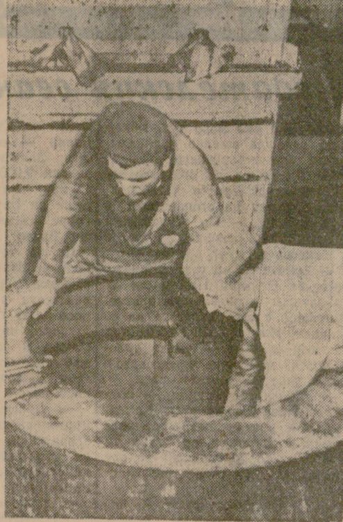
Мониторите Симеон Димчев и Ангел Стоилов опяват ситата на центрофугите в захарната фабрика при Държавни захарни заводи в Г. Оряховица. Сега там се бърза с ремонта на машините.
