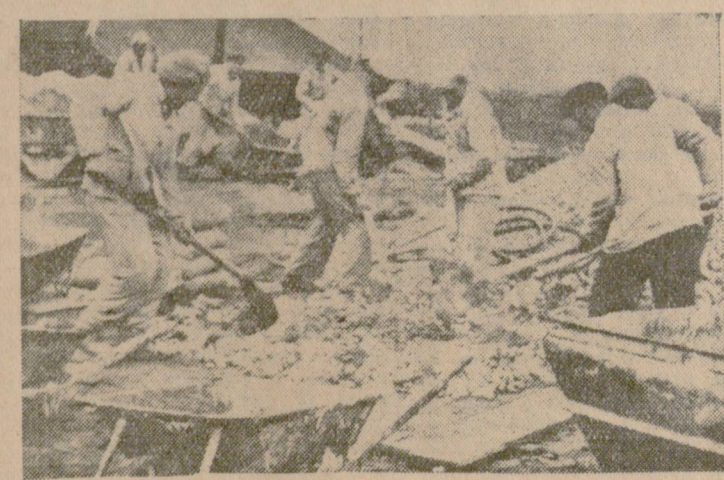
Макар бетонообработката да не е още докарана, бетончиците от бригадата на Недялко Куцаров бързат да използват времето, за да положат основите.
