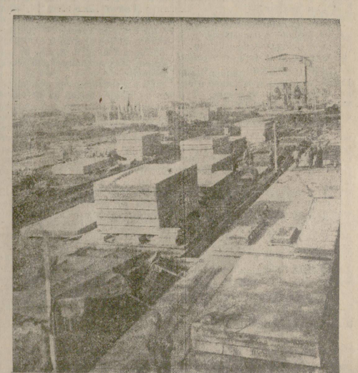
Строителството на Металургичния комбинат „Кремиковци“ край София ще се извършва изключително със сглобени елементи. Усилено се изгражда централната строителна база — огромна строителна база, която заема 600 декара площ и ще произвежда за нуждите на комбината два милиона и 500 кубически метра бетонови разтвори и сглобяеми елементи. На снимката: Общ изглед от централната строителна база на Металургичния комбинат „Кремиковци“.
