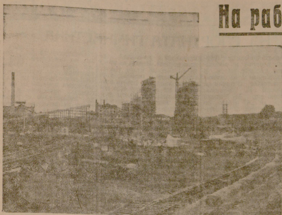
НА СТРОЕЖА НА ТЕЦ
