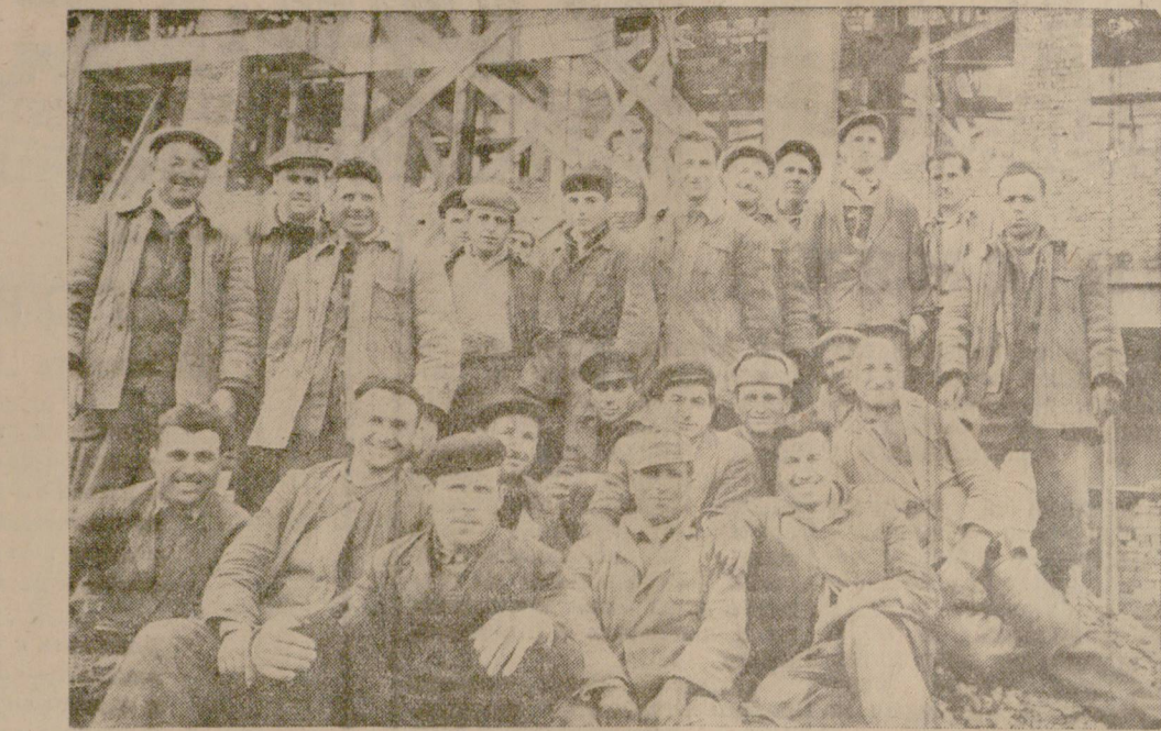
На новия консервен комбинат в гр. Павликени работят строителите от зидарокофражистката бригада на Къно Василев Кънев и бетонниците от бригадата на Ахмед Исупов. Зидарите изпълняват средно нормите си 160 на сто, а бетонниците — 180—200 на сто.
