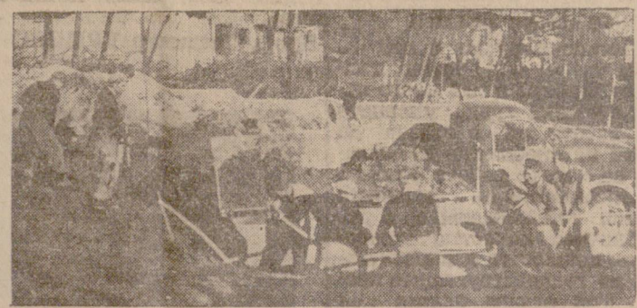
На своя трудов пост са работниците от изкопийско-бетонджийската бригада на Илия Тодоров. Въпреки трудностите на сезона те подготвят основите на бъдещия жилищен блок на Градския народен совет — Търново.
