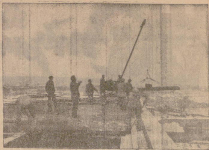
С неотслабващ темп се строи винарската изба в гр. Свищов. Бригата на Иван Ченев бърза да постави покрива, за което се употребяват 200-килограмови панели. В тази производствена операция се използва и малък кран „Пионер“.
