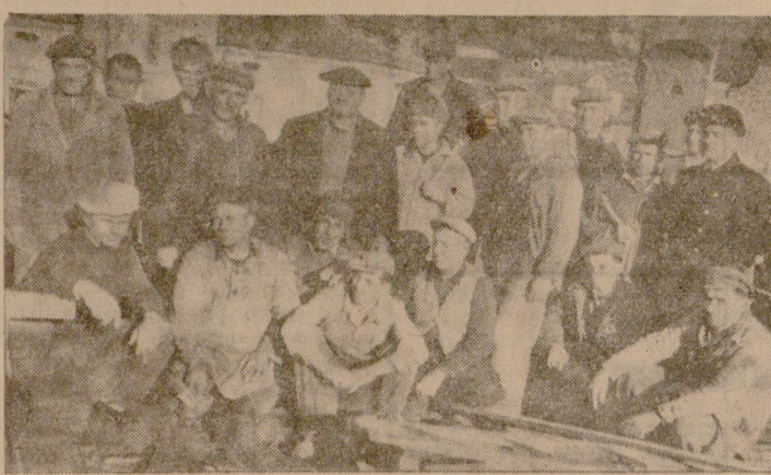
На разширението на читалищния дом в с. Сухиндол работи строителната бригада с ръководител Кольо Хр. Цончев. Тя редовно изпълнява трудовите си норми 150 на сто.
