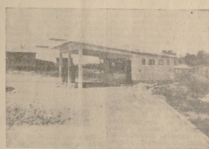
Неотдавна завърши строежа на новата бензиностанция в гр. Свищов.
