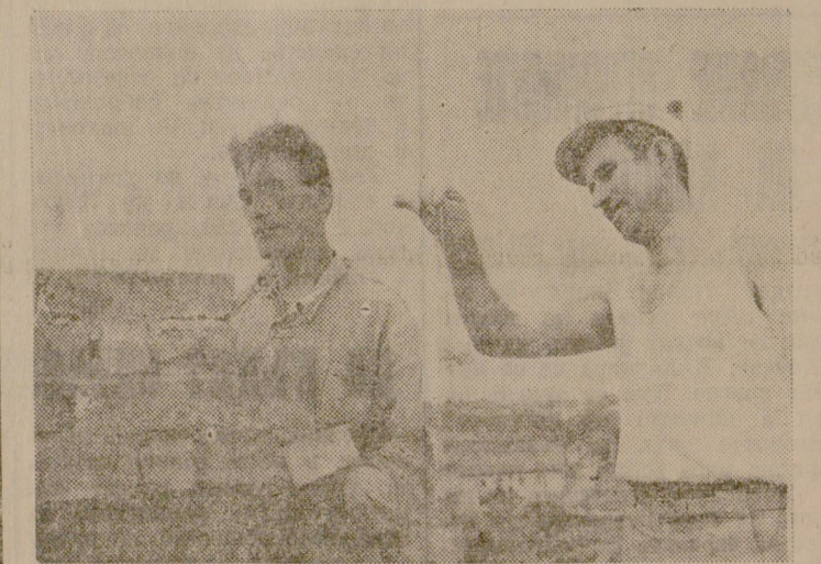
Строителната бригада на Петър Грозев довършва елеваторната кула на ф-ка „Билсан“ в Търново, височина над 30 метра. На снимката: Майсторът Иван Петров поставя последната тухла на кумина за огън. Опитният бригадир проверява правилно ли е изграден.
