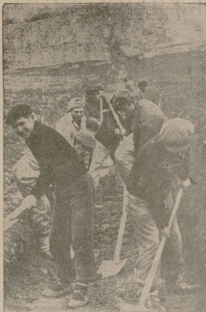
Не стихва трудът на изкопите за напорния тръбопровод. Снимка: Ив. Воденичаров
