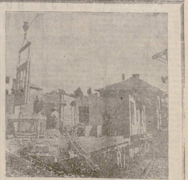
Започнал е монтажът на първия етаж. Кранът подава стенна панела.
