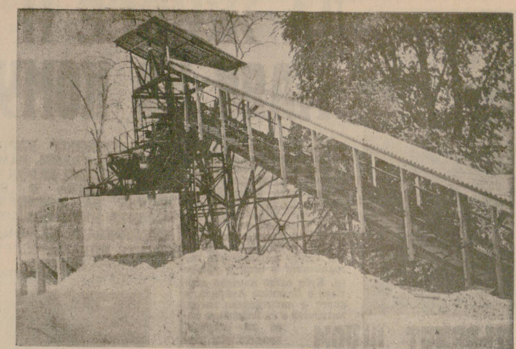
По пътя на малката механизация и техника в Бетонния център — В. Търново е направена промишлено-пресевна и сортировъчна инсталация за пясък и чакъл. С тази инсталация се промишват качествено на смяна 90 куб. м инертни материали
