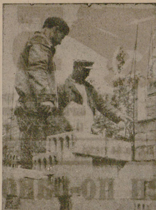
Бригадирът Марин Ковачев наблюдава и ръководи първите стъпки на Тодор Русев в строителната професия.
