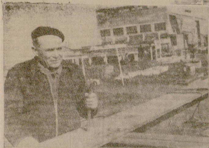
На Металургичния комбинат работи и германският специалист Кноф Паул, който ръководи монтирането на мощен кран за коксохимическия завод.
