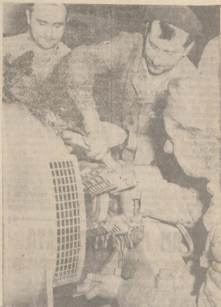
Зеното с ръководител Иван Стефанов започна ремонта на генератор № 2.
