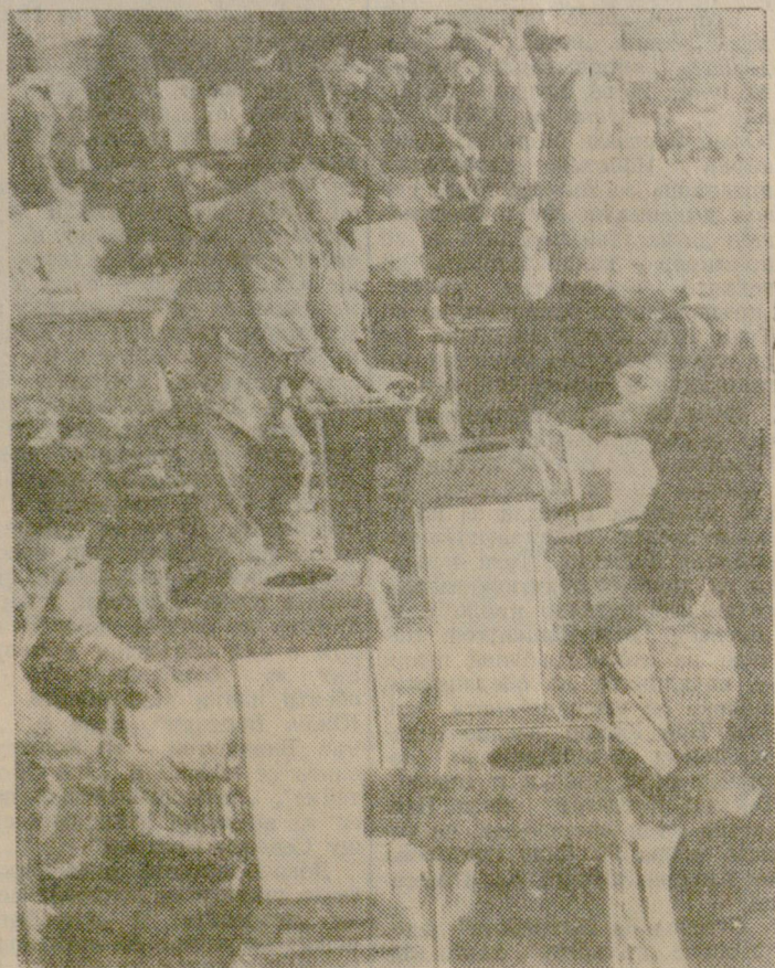
В участника за отоплителни пещи към ДИП „Металургия“ — Горна Оряховица е пуснат в действие автоматичен конвейер за поточно производство на пещи. С помощта на този конвейер бригадата на Антон Пенчев на всяка шеста минута дава готова пещка.
