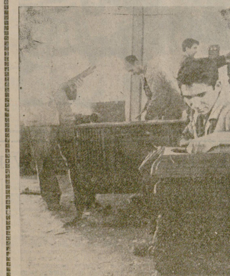
Колективът на работилницата за ремонт на печки при ТПК „Метал“.
