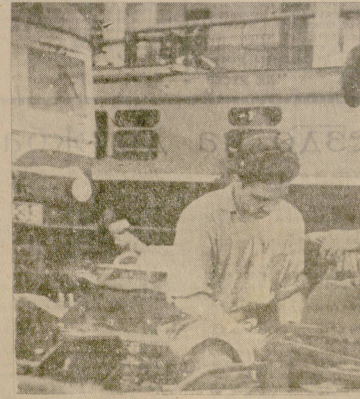
Шлосерите Васил Станчев и Алекси Николов от депо за електровози — гара Горна Оряховица демонтират тягов двигателят на електровоз.
