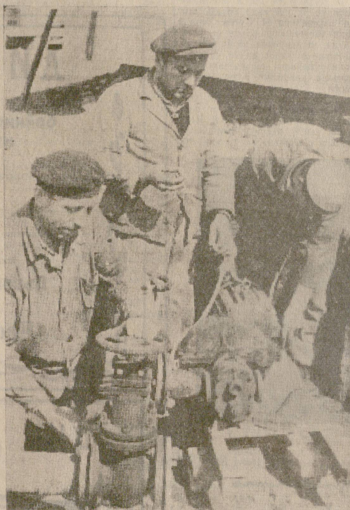
Огнярите от бригадата на Татю Пенчев в ДНП „Мизия“ с. П. Тръбеш извършват преустройството на парен котел за използване мазут вместо въглища, като монтират и нов парен мазутен котел със съответната инсталация и резервоар.
