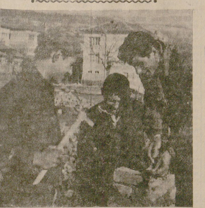
Училището по сградостроителство към Строителния техникум „Г. Димитров“ — Велико Търново подготвя всяка година по 50—60 млади строители. НА СНИМКАТА: Курсистите Кемал Османов, Никола Иванов от I „а“ курс извършват тухлена зидария, под ръководството на Божил Печанов.
