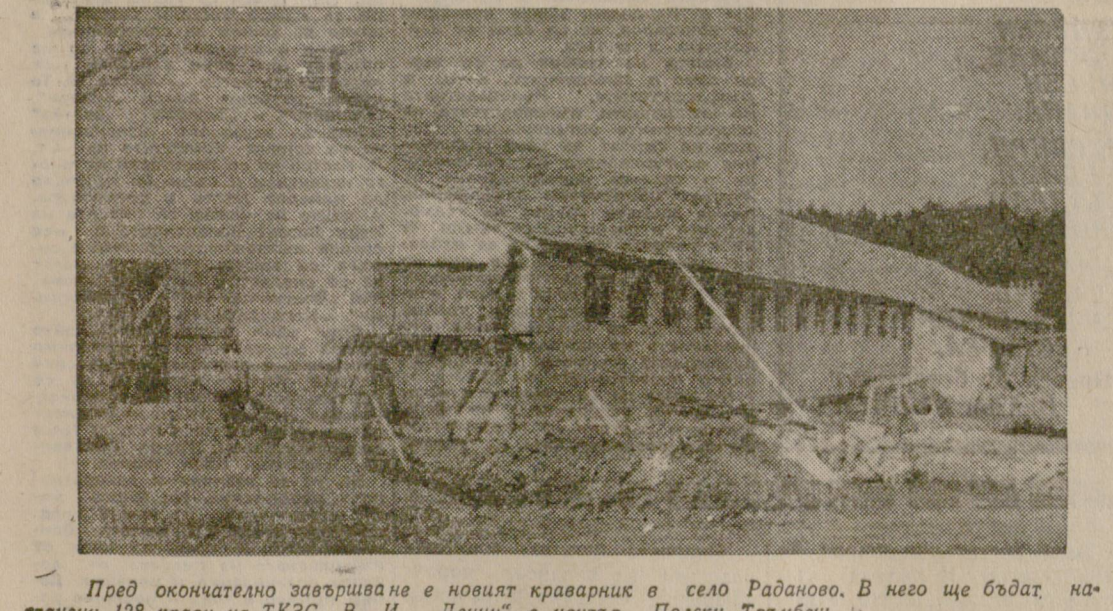
Пред окончателно завършване е новият краварник в село Раданово. В него ще бъдат настанени 128 крави на ТКЗС „В. И. Ленин“ с център Полски Тръмбеш, 11
