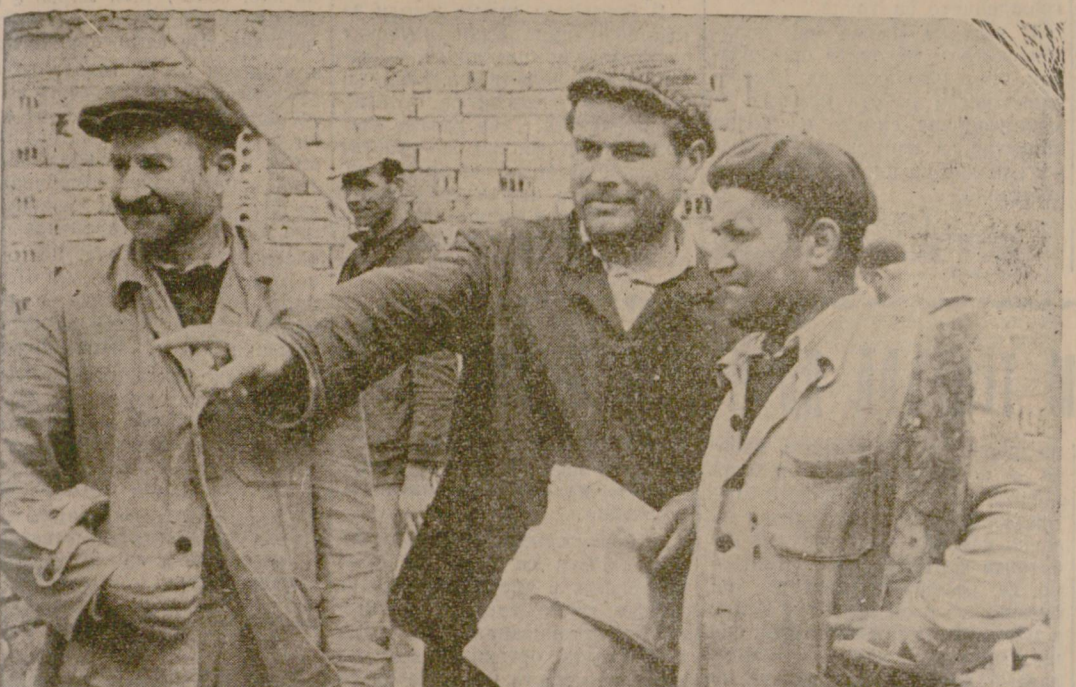
В дните пред Първи май зидарокофражистката бригада на Деню Събев, работеща на жилищния комплекс „Дружба“ във Велико Търново, за пръв път започна да прилага поточното строителство. По предварителен график се извършват — зидарията, кофража, арматурата и бетонизацията на тухла по начин създава условия бригадата значително да увеличи производството на труда и предсрочно да изпълнява производствения си план. НА СНИМКАТА: Деню Стоянов, Деню Събев и Тотю Митев уточняват предстоящата кофражна работа.
