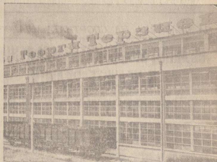
Новият цех за железобетонни траверси при завод „Георги Терзиев“ — Свищов.
