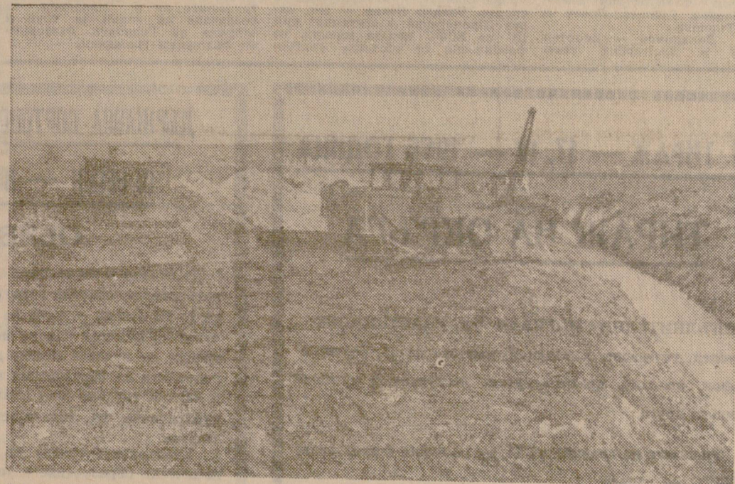
В Чапаево кипи усилен труд по мелиоративните обекти. Всеки ден от сутрин до вечер на водоема работят непрестанно два булдозера и един багер. Срочно трябва да бъде завършен обектът. Новият водоем ще побира 37 800 кубически метра вода.
