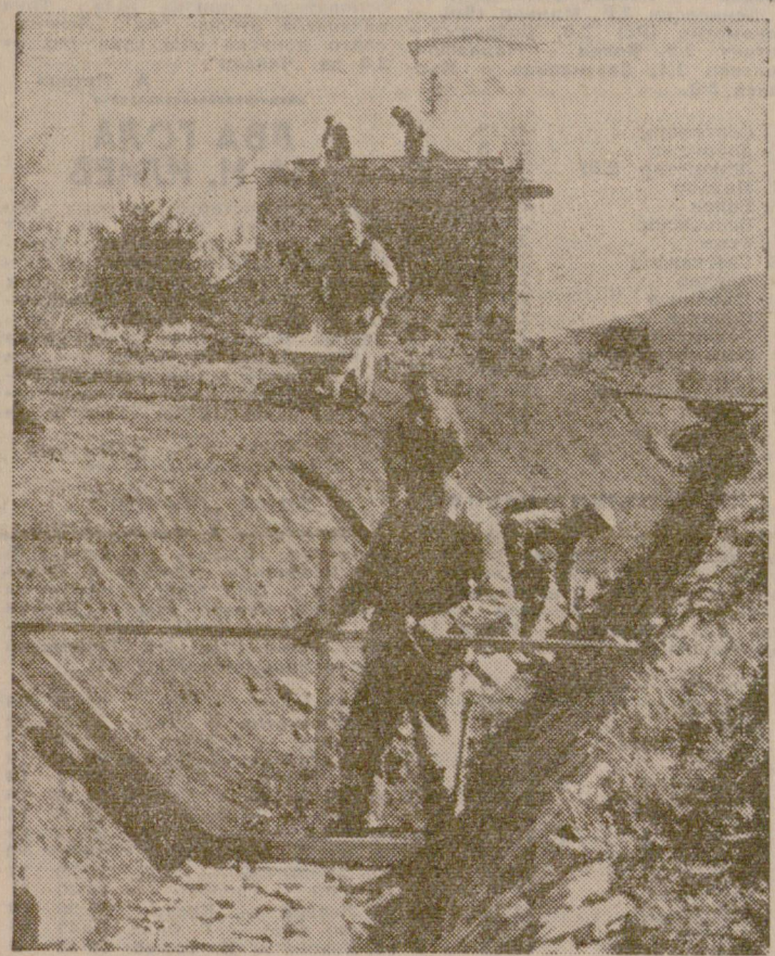
През тези топли пролетни дни усилено се работи по мелiorативните проекти в Лясковския кооператив. Един от тях е разширяването на помпната станция в Добри дял и главния канал. Тук работи строителната група на Васил Ридев, която бърза с рочно да завърши обекта.
