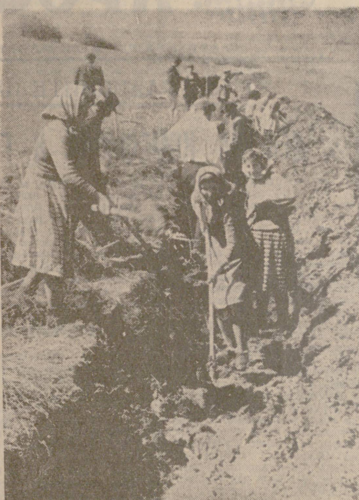
Около двадесет човека от комплексното звено на Дочка Пенев от Козарец довършват изкопните работи по разширението на левия канал на помпена станция „Балтеи“.
