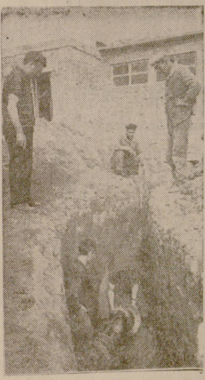
Строещт на помпената станция във Вълбица е в разгара си.
