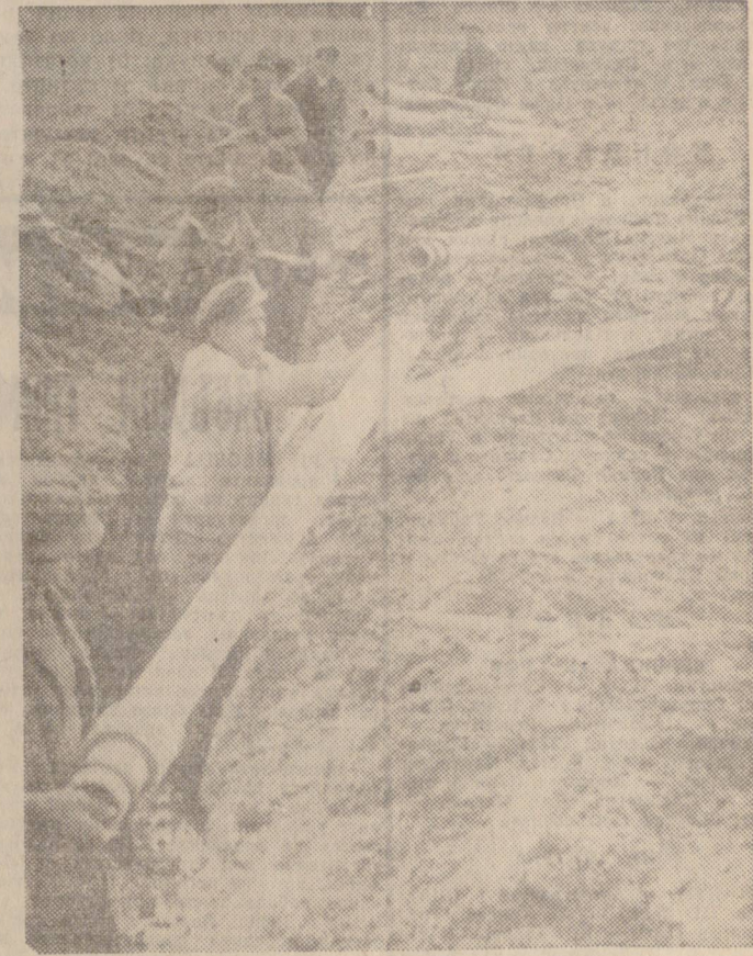
Кооператорите от групата на Никола Пенчев от село Върбинка бъдат да направят инсталацията за стационарно напояване на площ около 500 декара в местността Равнището. Всеки ден изкопават канали и полагат тръби над 120 линейни метра.
