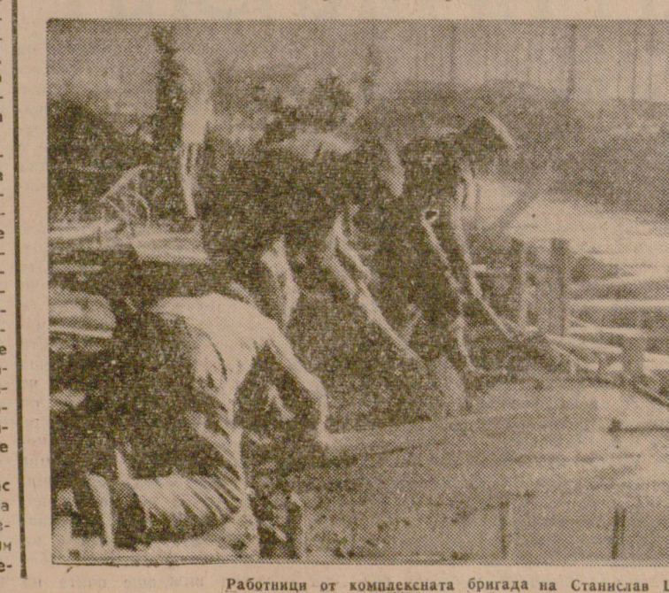
Работници от комбинатната бригада на Станислав Шомев издигат бетон.
