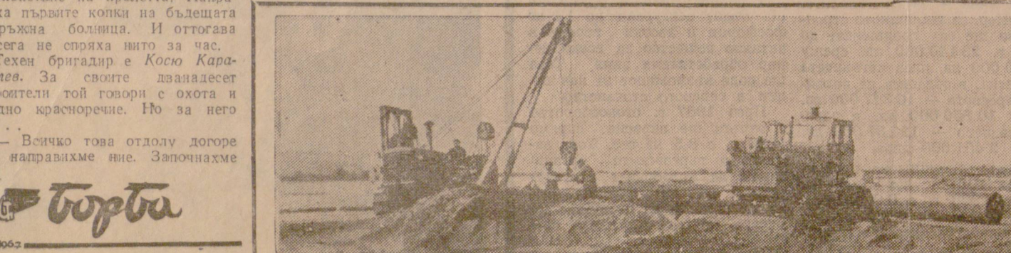
Земнарязът на площадката на строежа на Химкомбината в Свищов.
