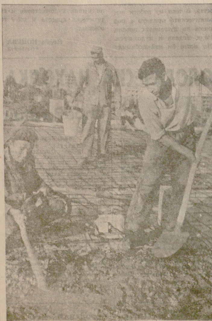
В Сянов се извършва надстройка на хотел „Дунав“. Строителите Борис Великов, Коста Макаров и Александър Иванов работят усърдно на строежа.
