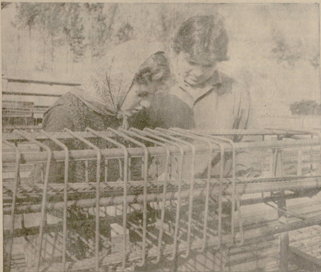
В откритата площадка на предприятието „Г. Терзиев“ — Свищов Надежда Тодорова е нов член за бригадата арматуристи на Бочо Филипов. Но Мария Цветанова има богат производствен опит и още в първите минути на работния ден е в помощ на Надежда.
